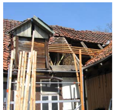
erste Sicherungsmaßnahmen im Dachbereich
