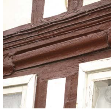
Detail – vorgerückte Füllhölzer
